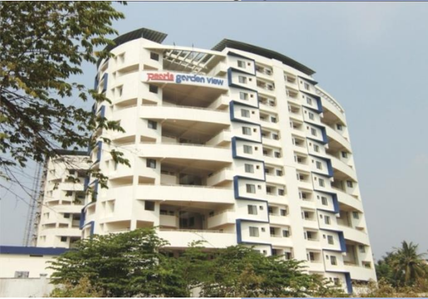
Actual Site Photographs
